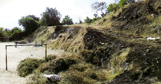
Terreno de la cancha de fútbol bajo el cual se construirá el sistema de laminado en la comunidad San Felipe II
