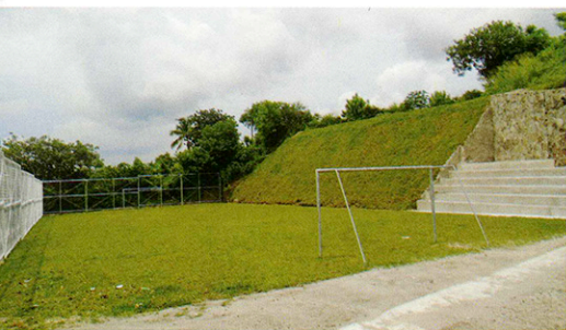
Cancha de fútbol construida sobre el sistema de laminado
