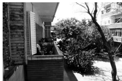
Vista ascendente del patio interior.
