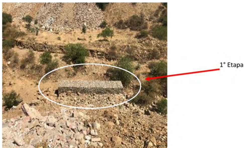
Figura 5. Construcción de gavión
