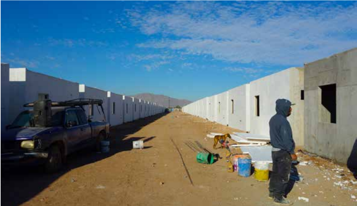
Fraccionamiento de vivienda social en construcción en la periferia de Mexicali.
