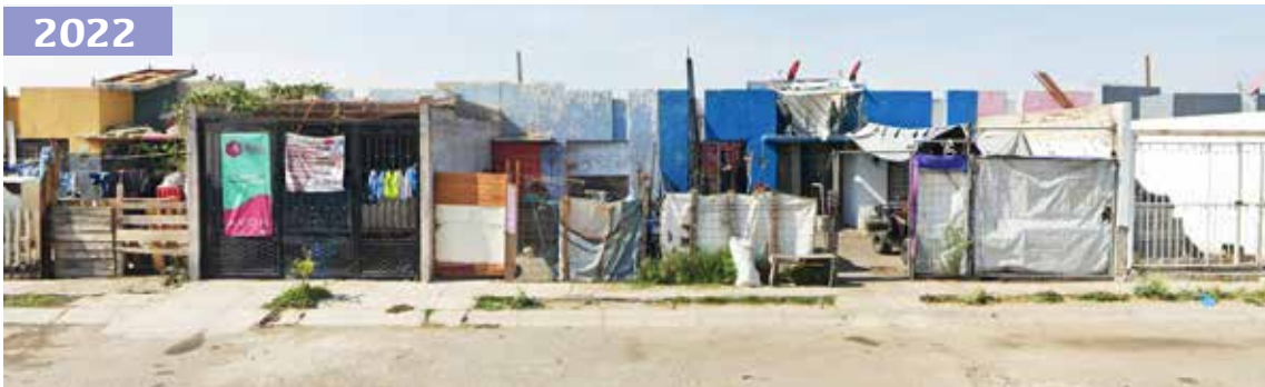
Reocupación precaria de las viviendas abandonadas.
