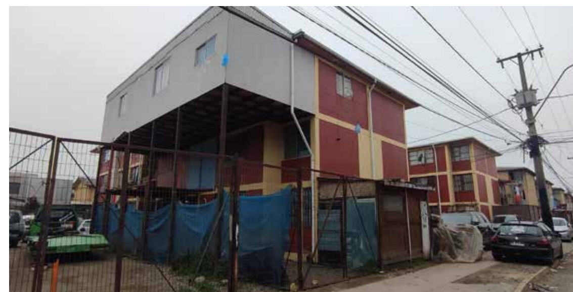
Ampliaciones múltiples realizadas por los habitantes en plantas bajas y altas, en edificios de vivienda social, Comuna de Puente Alto, al sur del Gran Santiago.
