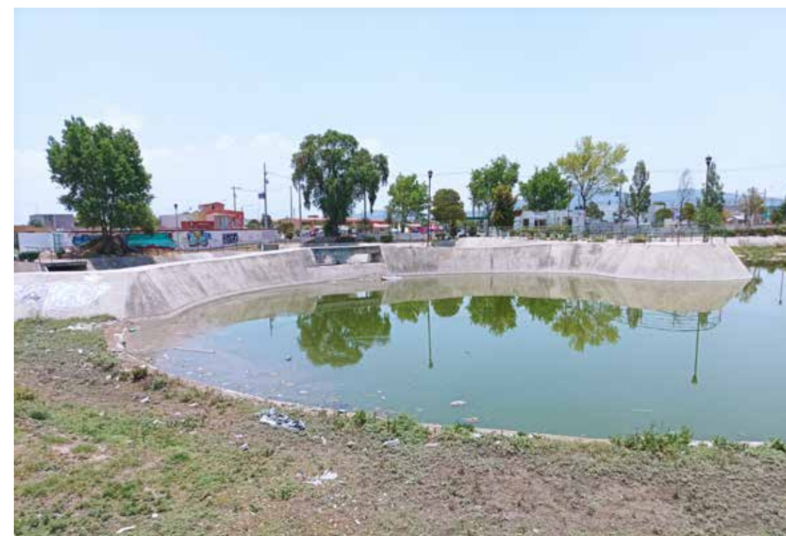
El deterioro avanzado del Geoparque y su laguna, en Villas de la Laguna, Zumpango.
