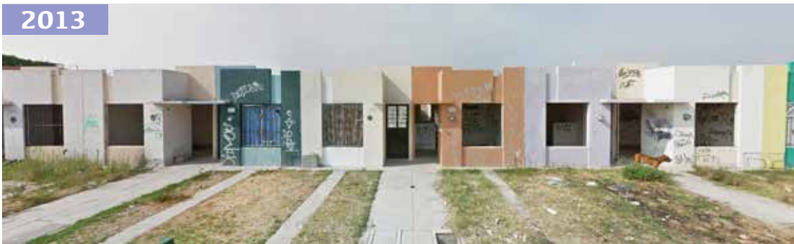
Abandono de numerosas viviendas.
