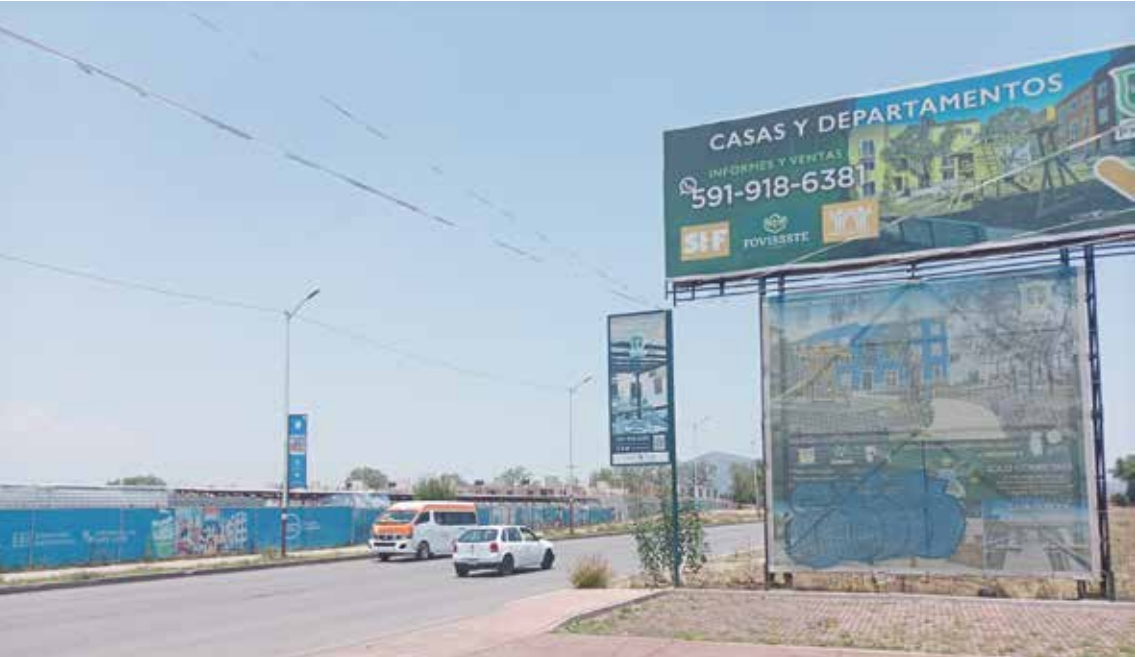
Nuevos conjuntos habitacionales en construcción, promocionados en Zumpango.
